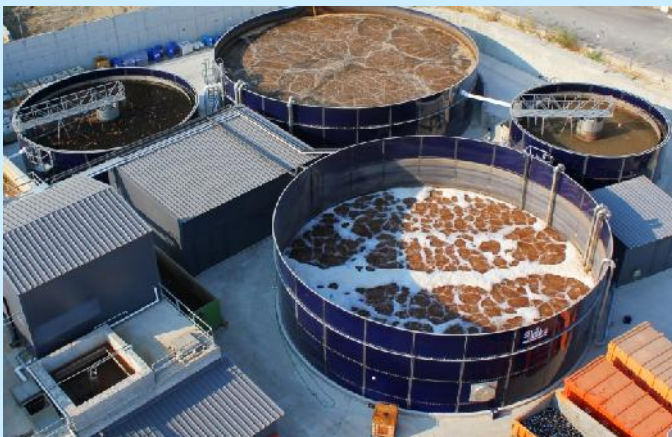
Σύστημα MBBR- Προκατασκευασμένες δεξαμενές από χάλυβα..
