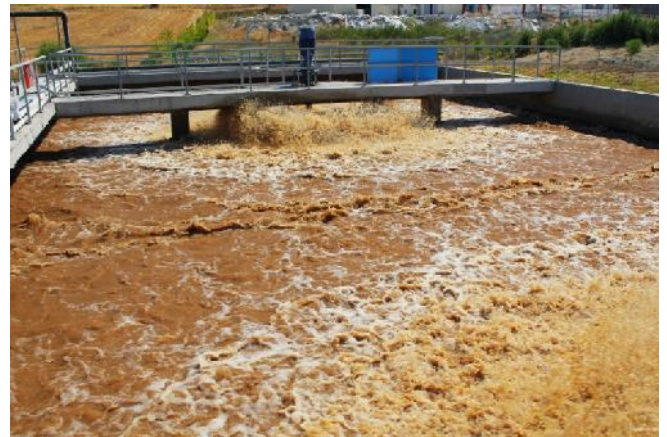
Δεξαμενή Αερισμού με επιφανειακούς αεριστήρες.
