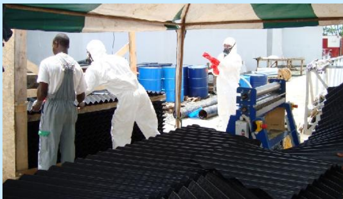
Συναρμολόγηση Βιόφιλτρου.
